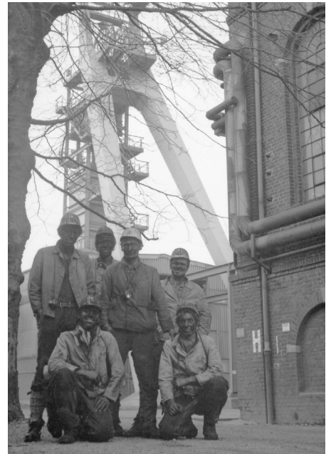
nach der Schicht vor General Blumenthal, Schacht 3, 1983
