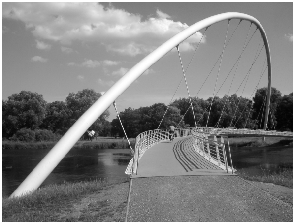
Bild 8 Tiergartenbrücke über die Mulde in Dessau: 2000 (Foto: D. Münzberg)
