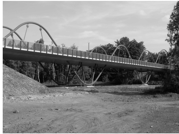
Bild 9 Brücke Ripshorster Straße in Oberhausen: 2008 (Foto: G. Schülke)
