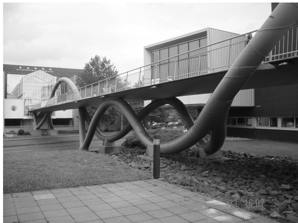
Bild 1 Fußgängerbrücke Erinpark, Castrop-Rauxel: 1995 (Foto: Archiv Polónyi)
