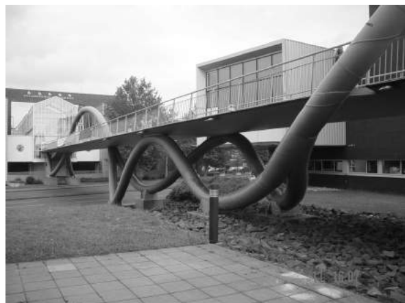
Bild 1 Fußgängerbrücke Erinpark, Castrop-Rauxel: 1995 (Foto: Archiv Polónyi)
